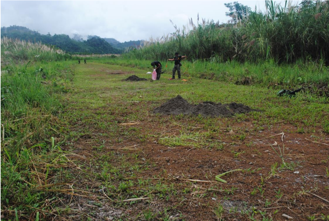
Preparación de cargas explosivas para destrucción de pistas clandestinas
